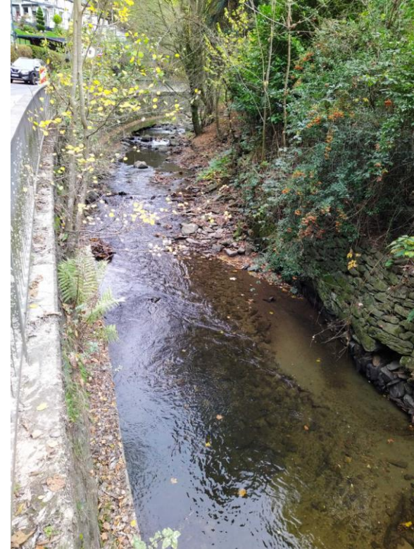
Eschbach nicht sanierter Bereich
