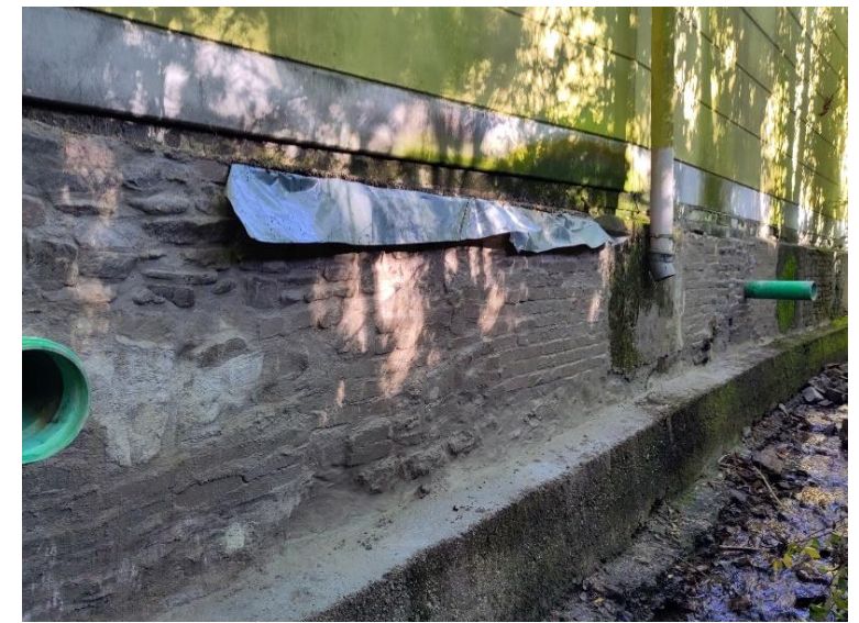
Ufermauer nach Reparatur
