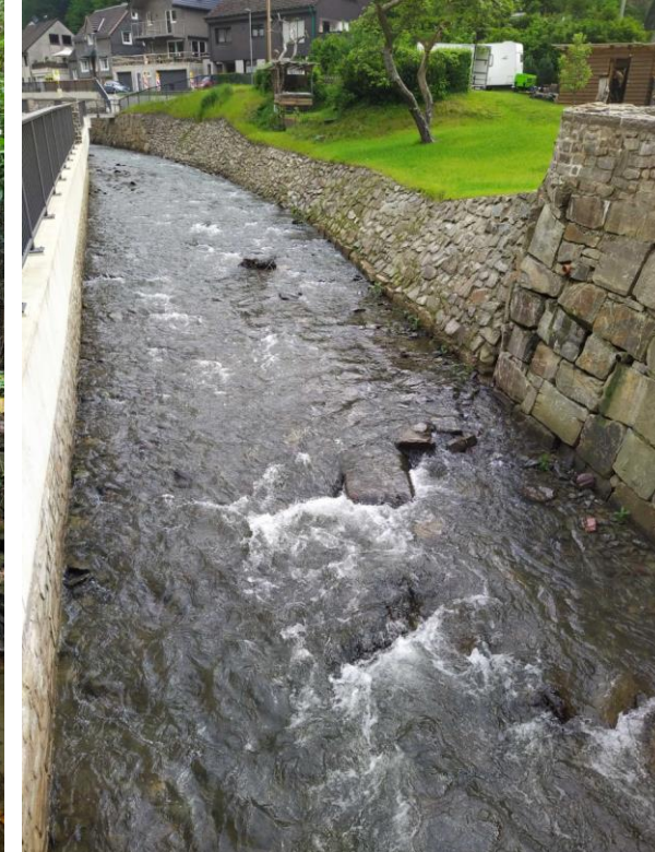
Eschbach sanierter Bereich
